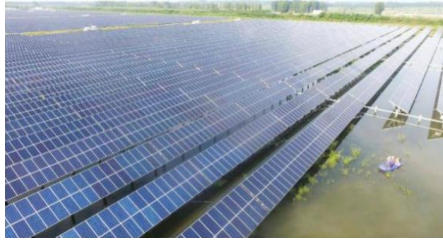
图 2-3 固定式支架示意图
